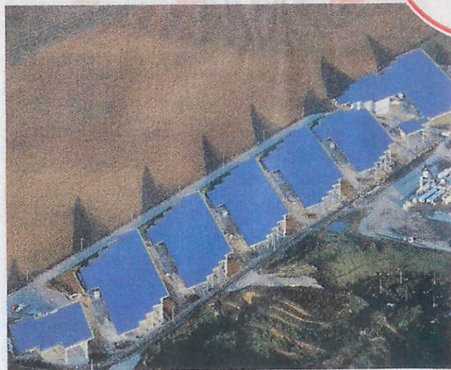
Un modèle de zone industrielle à énergie positive
